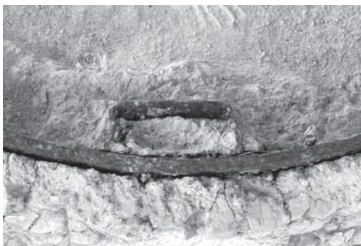
Εικ. 9 Σιδερένιος σύνδεσμος σχήματος Π από την άμαξα Α.
